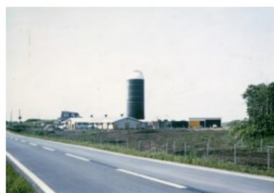
新酪農村建設事業によって建設されたサイロ・牛舎など
